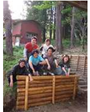
ログ風の土留め
