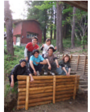
ログ風の土留め (メインホールピロティ)
